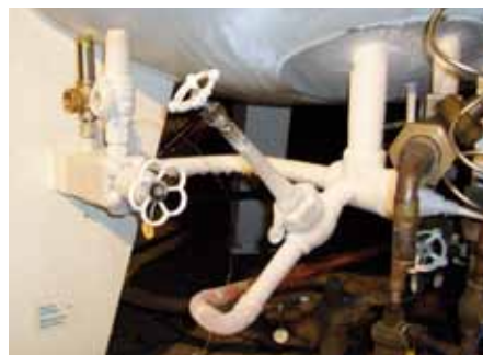
Das Test-Sicherheitsventil rechts zu Beginn des Versuchs (oben) und im vereisten Zustand nach 4 Stunden (unten)
