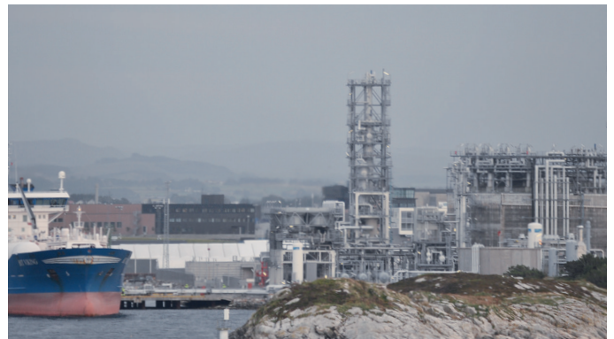
The LNG terminal in Stavanger harbour
